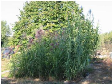
Nella foto: esempio di impianto di fitodepurazione a flusso sub-superficiale verticale piantumato con *Arundo donax L.*, in cui si può apprezzare il basso impatto paesaggistico (fonte: eFrame). In questa tipologia di impianti le acque reflue sono applicate in superficie, percolano lungo il profilo del suolo ricostituito verso il fondo impermeabilizzato della vasca, da cui sono raccolte post trattamento fitodepurativo
